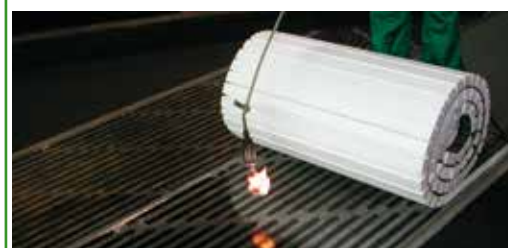
I rotoli di THERMOBASE srotolati sulla superficie appena sfiammata verranno fatti aderire al TECTENE BV STRIP EP mediante pressatura su tutta la superficie del rotolo mediante semplice calpestio dell'operatore (da effettuarsi su tutta la superficie del pannello o rotolo)
