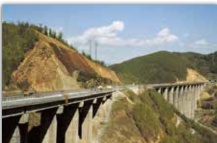
VIADOTTO "HEMUS" BULGARIA
