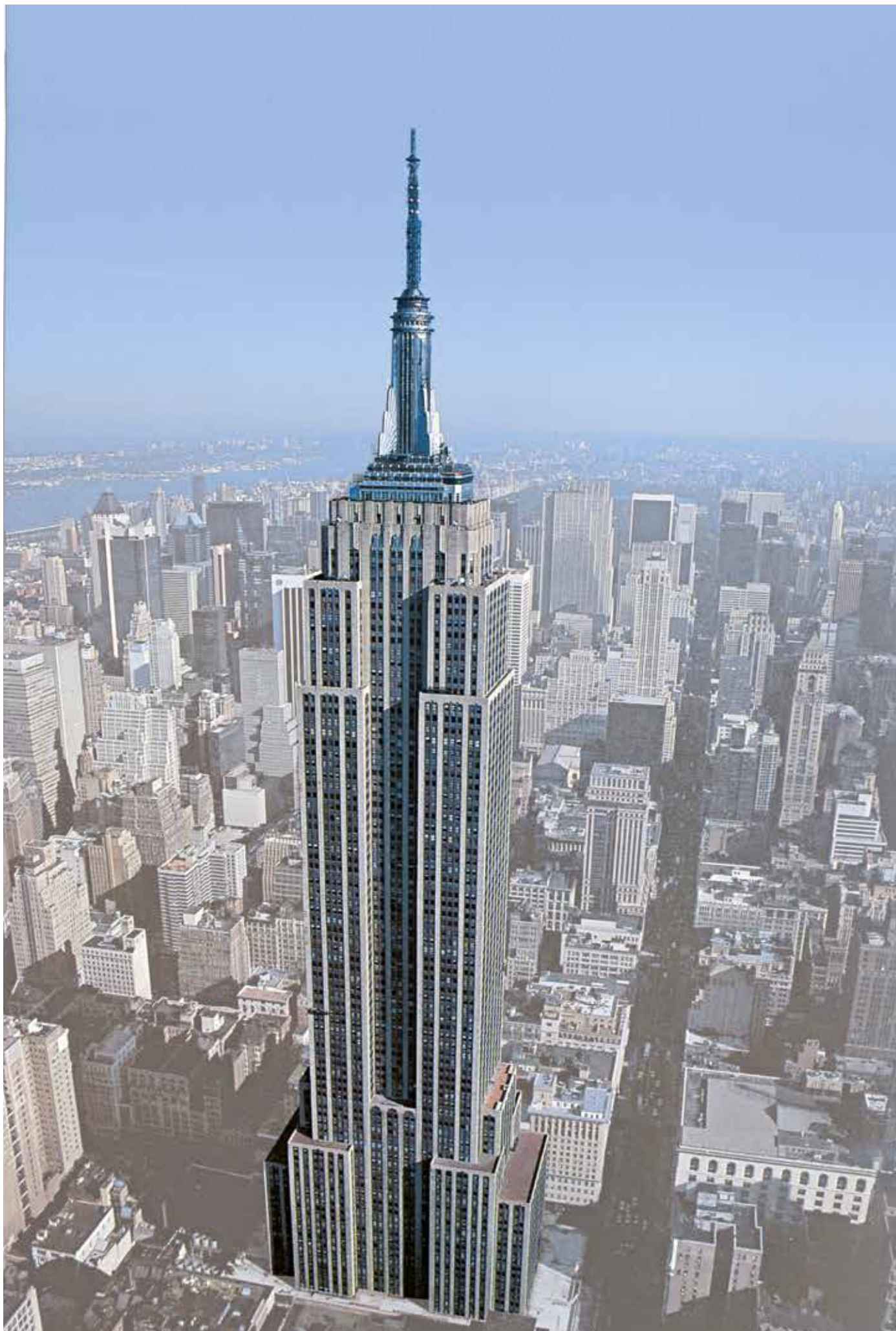
REFERENZA: EMPIRE STATE BUILDING - New York - U.S.A. - Prodotti utilizzati: linea adesivi e sigillanti cementizi.
