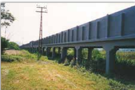
CANALE IDROELETTRICO Piemonte - ITALIA
