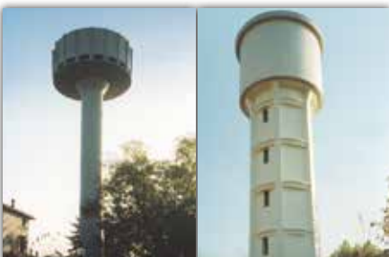
TORRI PIEZOMETRICHE Bologna - ITALIA
