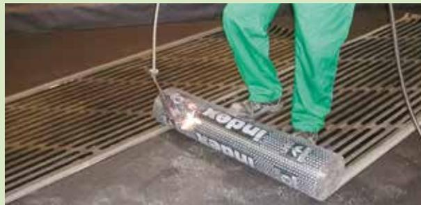
Pose à la flamme de la face inférieure de TECTENE BV STRIP EP
