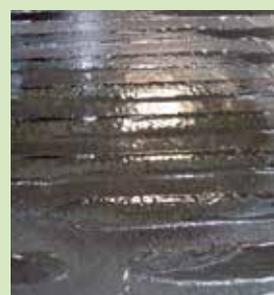
En insistant avec le flammage, les bandes thermoadhésives assumeront une consistance semi-liquide et brillante: la surface sera prête à recevoir la pose des panneaux ou des rouleaux d'isolant
