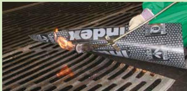
Pose à la flamme des chevauchements latéraux et des chevauchements de tête, de sorte à garantir un scellement parfait par rapport au passage de la vapeur
