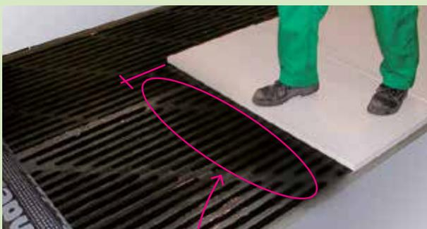
Les panneaux d'isolant couchés sur la surface tout juste flammée seront faits adhérer au TECTENE BV STRIP EP en pressant sur toute la surface du rouleau par simple piétinement de l'opérateur (à effectuer sur toute la surface du panneau)
