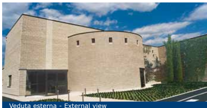
Veduta esterna - External view
