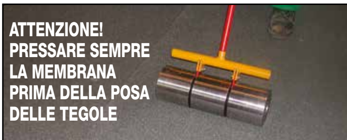
8. Pressatura generale prima della posa delle tegole
